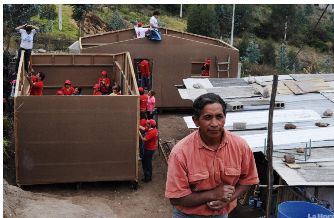
Figura 4.13 Un techo para Pisulí
