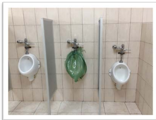
Figura 60. Anexo 24 visita a la TTS.
