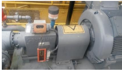
Figura 2. 21 Cámara de empuje. Fuente: Rengifo, J., 2014
