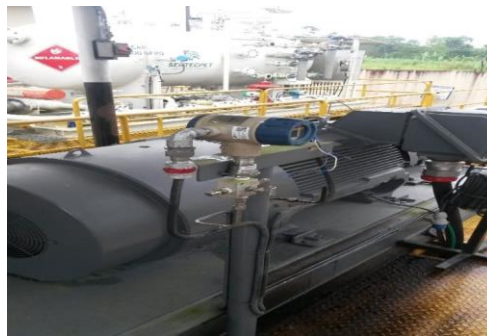
Figura 2. 19 Motor de inducción para la bomba horizontal.
