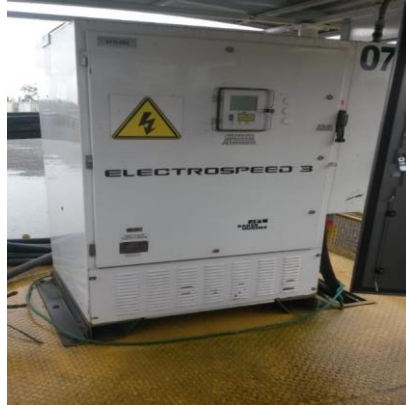
Figura 2. 16. Variador (VFD). Fuente: Rengifo, J., 2017
