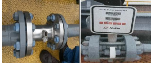
Figura 2. 23 Medidor de turbina (Izq.) Analizador MCII acoplado a la turbina
