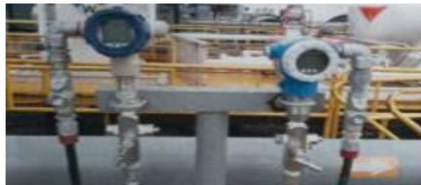
Figura 2. 24 Transmisores de alta y baja presión (Izq –Derch.)
