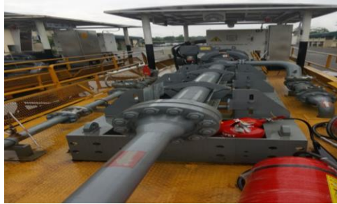
Figura 2. 22 Bomba Horizontal centrífuga. Fuente: Rengifo, J., 2017
