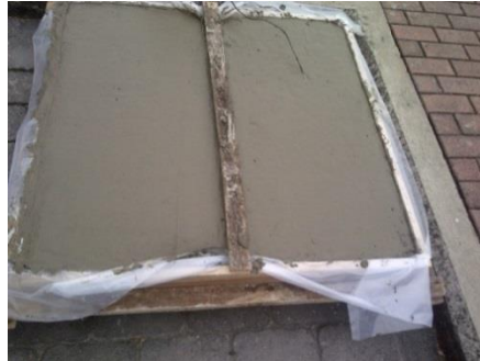
Gráfica 5.8: Acabado final de la Losa.
