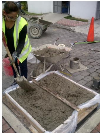
Gráfica 5.6: Fundición de Losa de Pavimento
