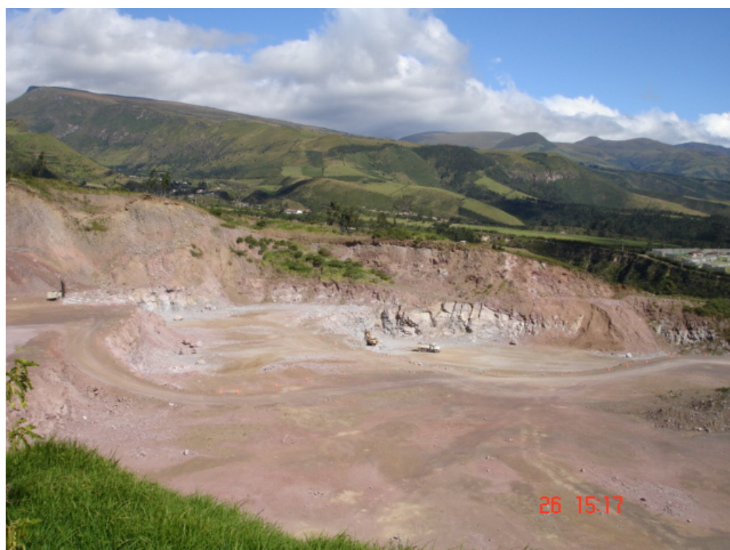
Foto 4.1. Labores de transporte de material
