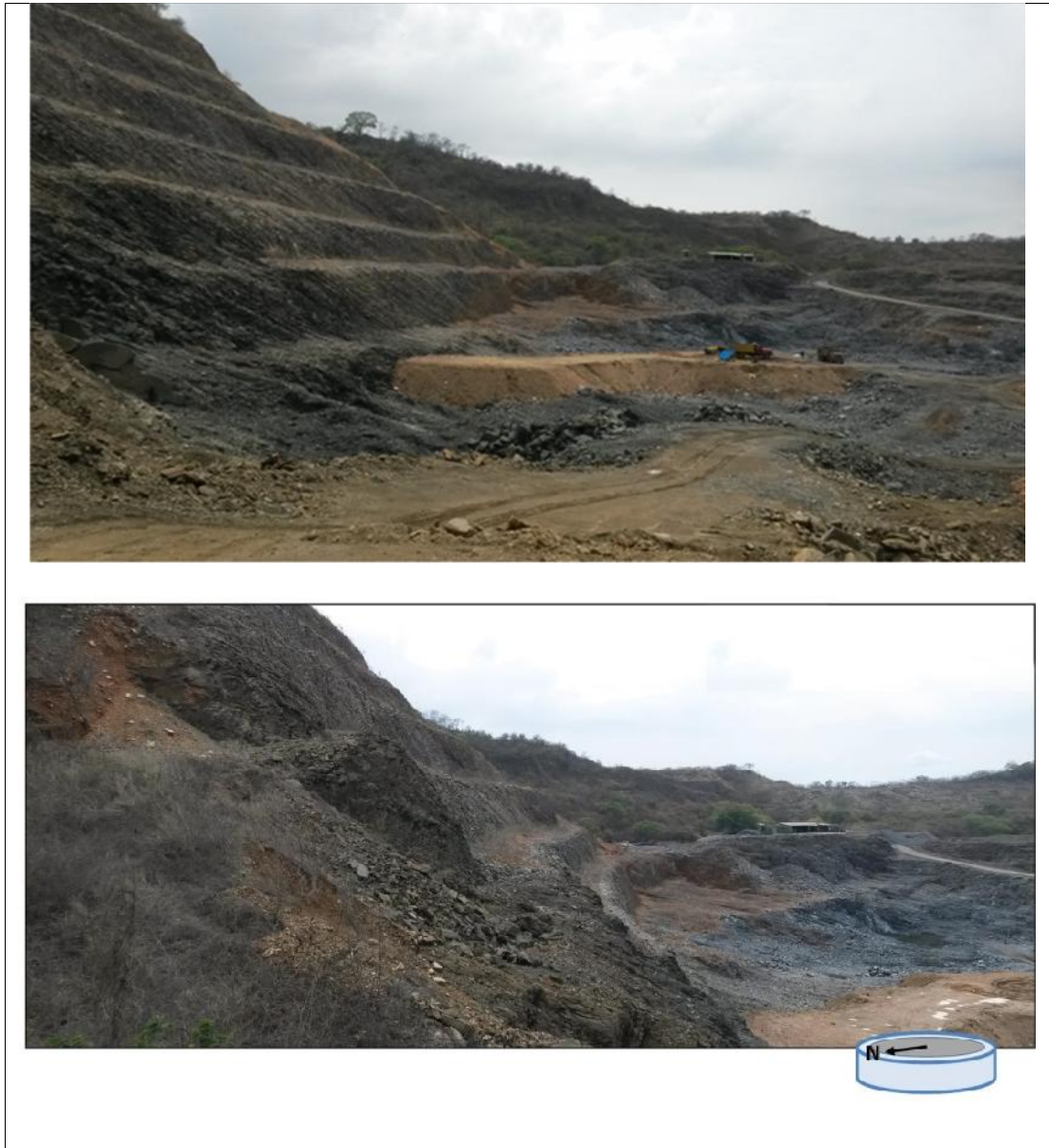
Figura 85 Vista Panorámica del Talud de estudio.
