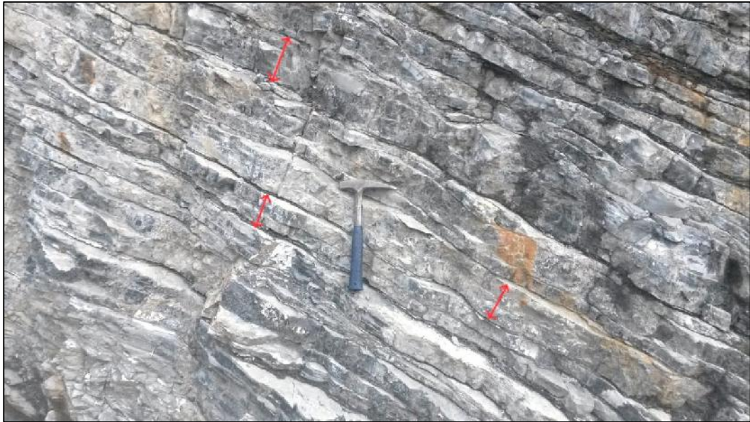
Figura 37 Detalle de la separación de juntas en la EGM 4. Donde la separación de juntas mayormente es menor a 20 cms.
