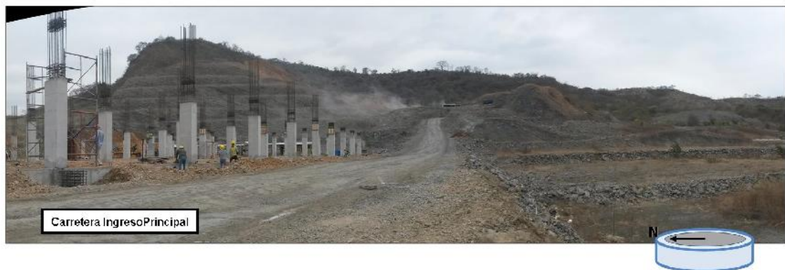
Figura 86 Construcción del Complejo Hospitalario 'Interhospital'.
