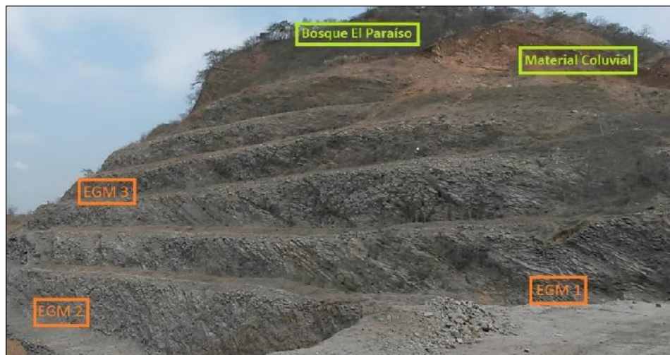
Figura 40 Ubicación de estaciones geomecánicas (1, 2 y 3) en el talud
