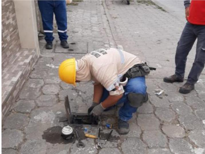
**Figura 16: Revisión de Medidor en campo por orden de Crítica**
