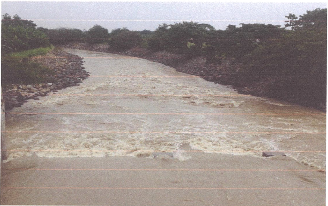
Salida de caudal del río Bulubulu en el Bypass 2. Visita in situ en Bypass 2
