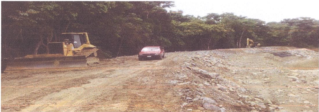
Visita a la zona del recinto San Mateo.Reparación del muro.
