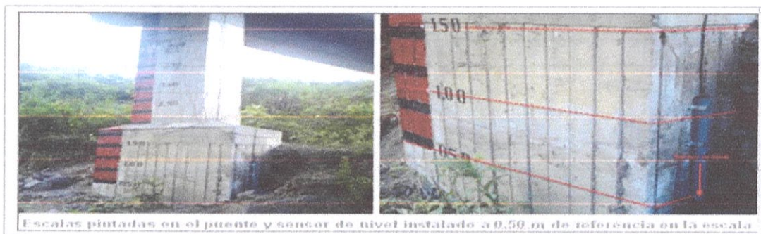
Figura 27. Escalas pintadas en un puente del río Frío en Honduras
