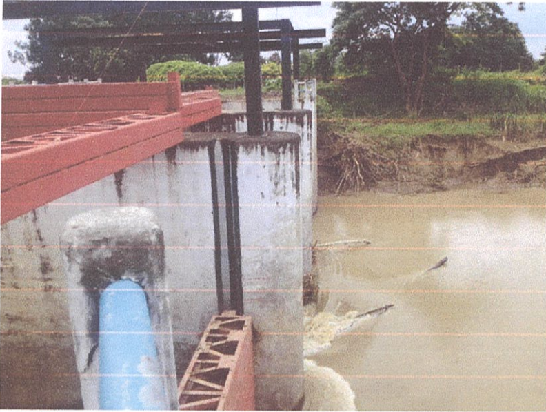
Reguladora del río Bulubulú o Bypass 2 Foto tomada 19 marzo de 2016
