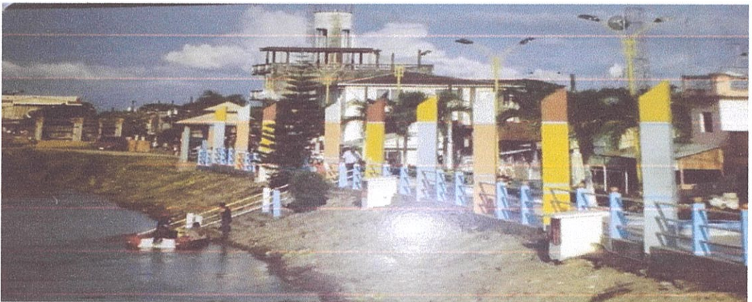
Malecón de la parroquia Taura del cantón Naranjal. Se observa la escalinata que sirve de control de umbrales de alerta para controlar el nivel del río Bulubulú.
