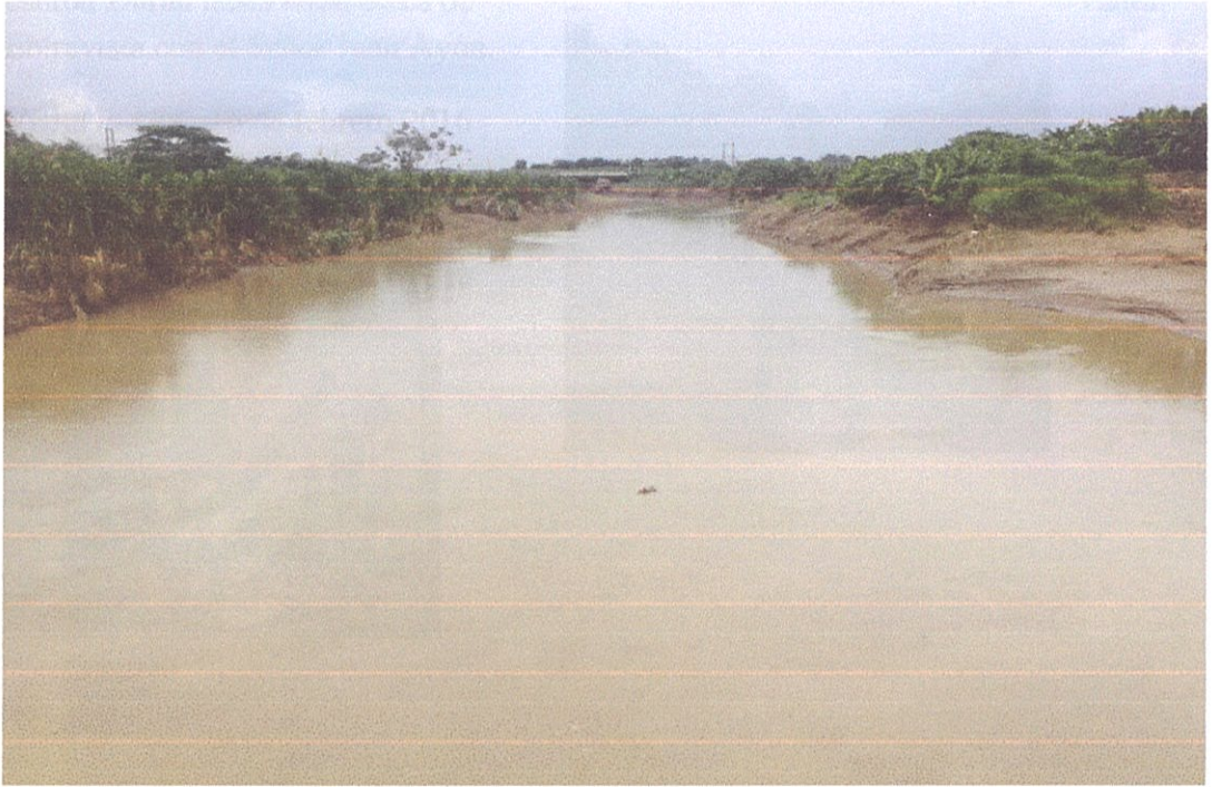
Ingreso de agua a las compuertas de la reguladora de caudal o Bypass 2.
