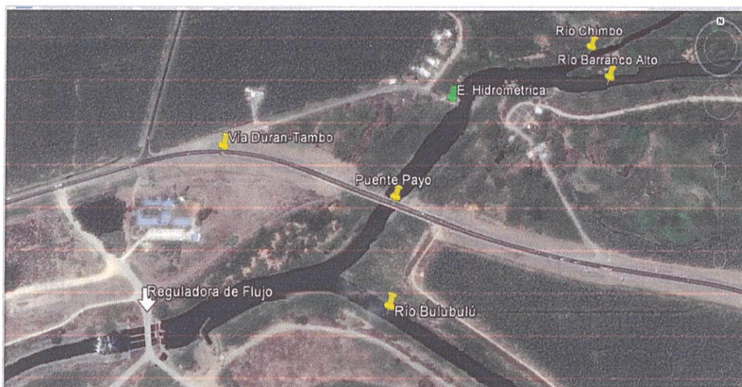
Figura 9. Derivadora de flujo de caudal o bypass 2, de los ríos Barranco Alto, Chimbo y Bulubulú en Puente Payo
