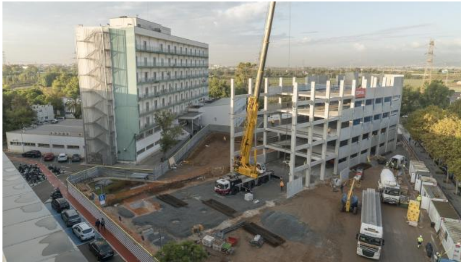
Figura 3. Edificio polivalente en construcción bajo metodología IPD (Salud, 2021)
