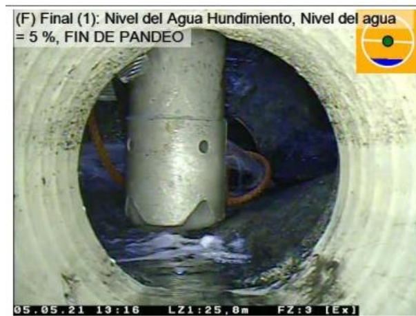
Figura 2.15 Tubería de PVC con pandeo. (INTERAGUA, 2021)
