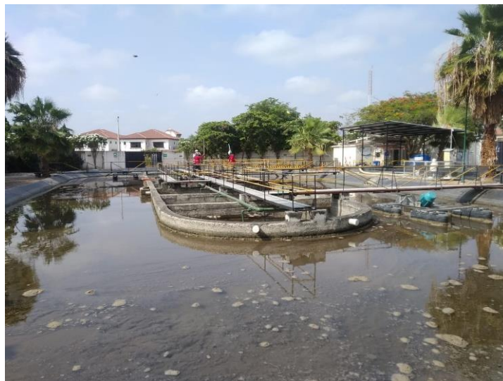
Figura 2.6 Piscina de la PTAR. (Autores, 2021).
