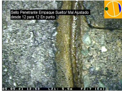
Figura 2.13 Sello Penetrante Empaque Suelto. (INTERAGUA, 2021)
