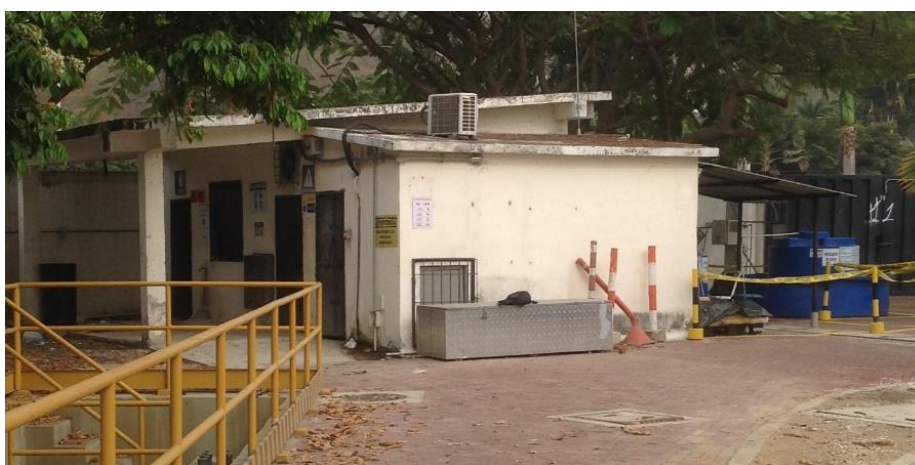
Figura 2.9 Estación de bombeo. (Autores, 2021).
