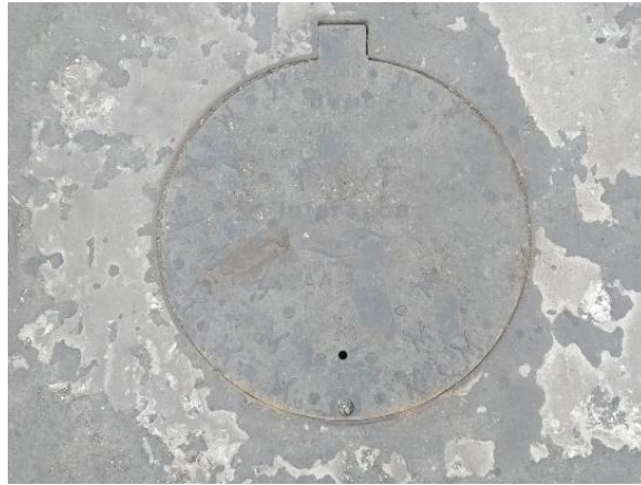
Figura 2.1 Tapa de una cámara de Inspección de AA. SS. (Autores, 2021).
