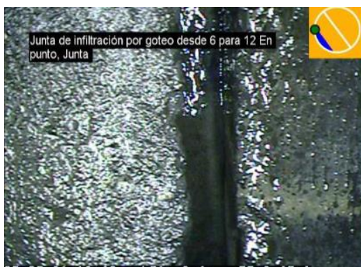
Figura 2.12 Junta de infiltración. (INTERAGUA, 2021)
