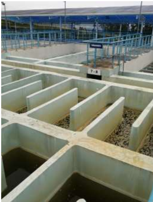
Imagen 2. PTAP Apatug – Sedimentadores
