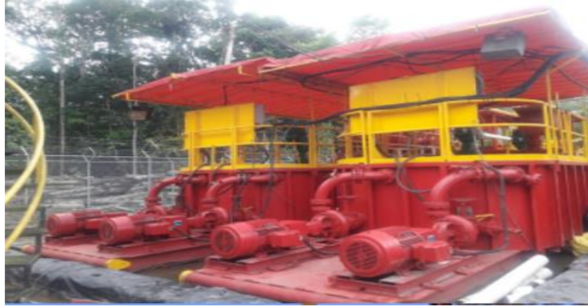
Figura 2-6 Tanque de procesamiento en pozo Tambococha D2 (2019)
