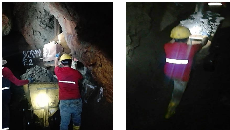
Figura 12 transporte tramo carro minero Fuente: Autores 2019
