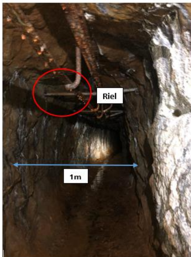
Figura 10: sección de la galería para el transporte por garruchas
