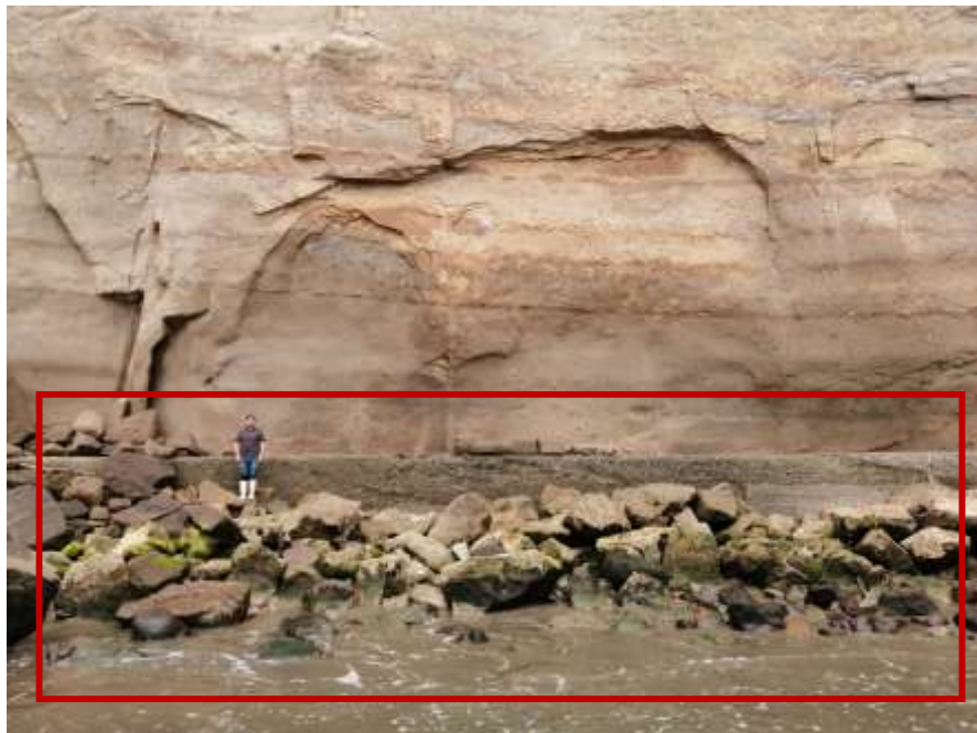
Figura 6.4 Muro electrosoldado de rocas implementado para evitar el desgaste de la base del acantilado por acción del fuerte oleaje.
