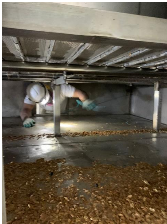
Anexo 17: Limpieza seca del horno con linterna de casco
