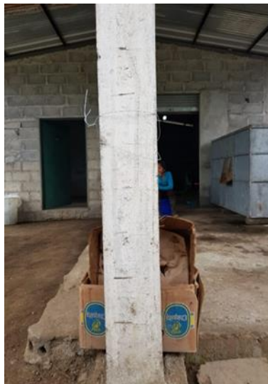
Figura 1.3 Distinta separación de estribos. [Pelayo & Ashby, 2020]
