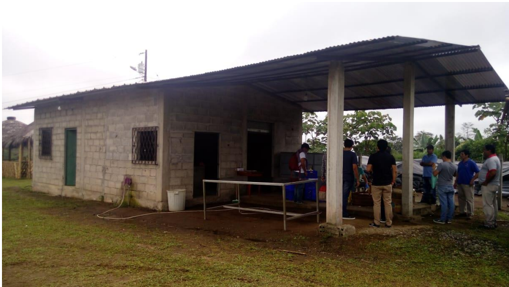
Figura 2.1 Infraestructura existente. [Acosta, 2020]
