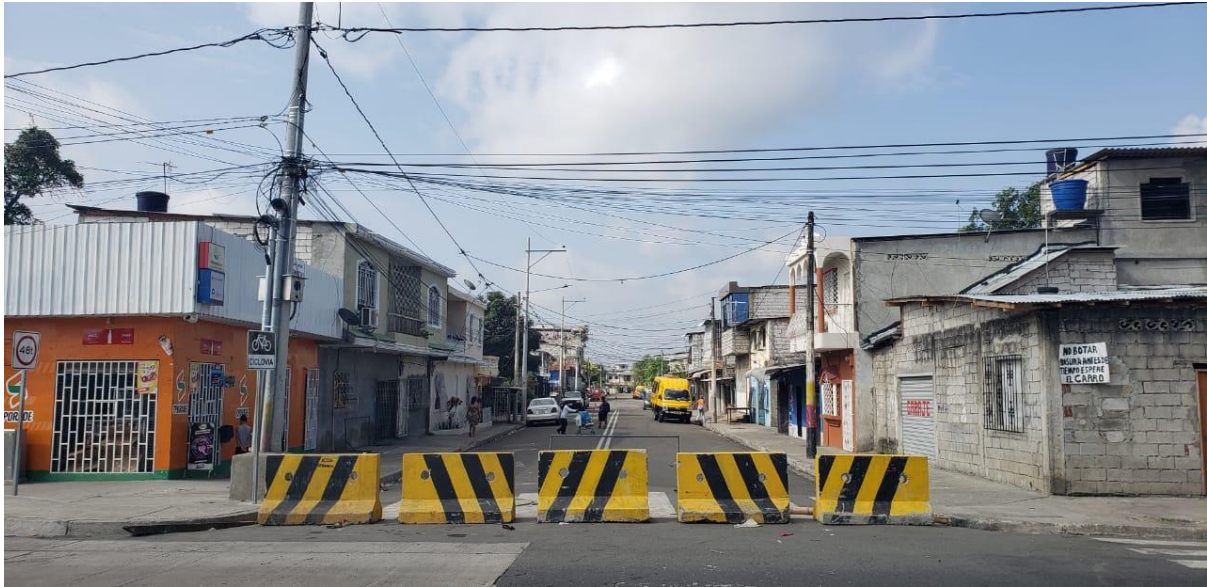
Gráfico 5.2.20 Calle antes de subir el puente de la A, otro lado de calzada. Guayaquil.
