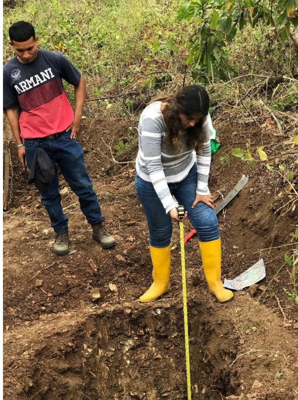
Medición de profundidad de calicata
