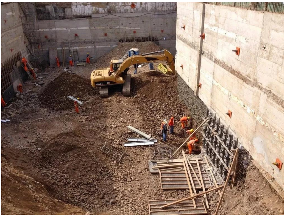
Figura 1.6 Pantallas impermeables de hormigón
