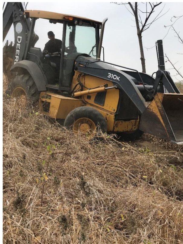
Desbroce de la retroexcavadora
