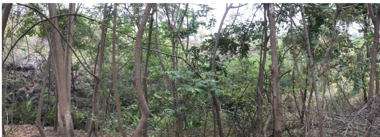
Figura 2.2 Inspección-Lado posterior de presa.
