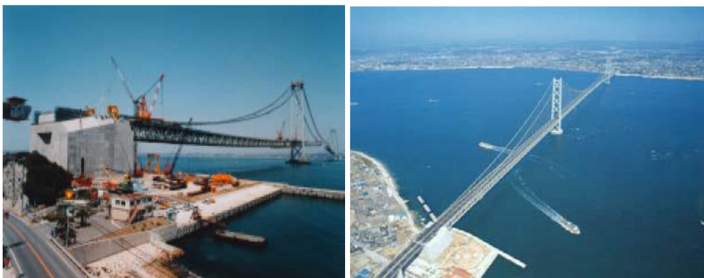
FIGURA 1.1. ANCLAJE DEL PUENTE AKASHI KAIKYO
