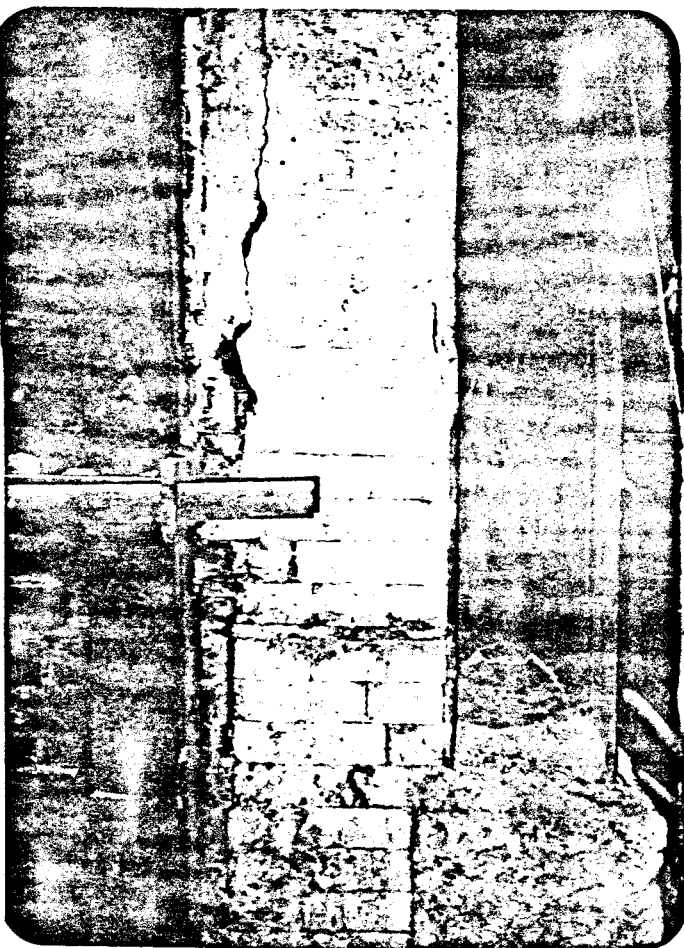
FOTO #4, FISURA PARED DELANTERA, CALD. #3
