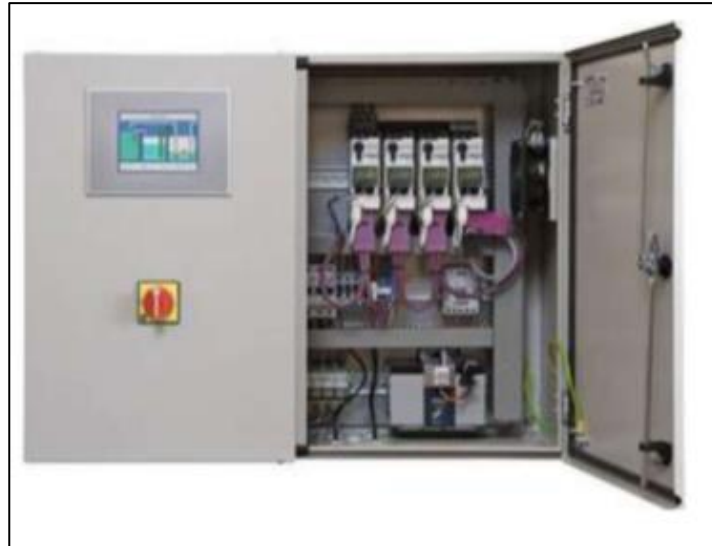
Figura 2.19 Panel de control de la planta [ATB Umwelttechnologien , s.f.]
