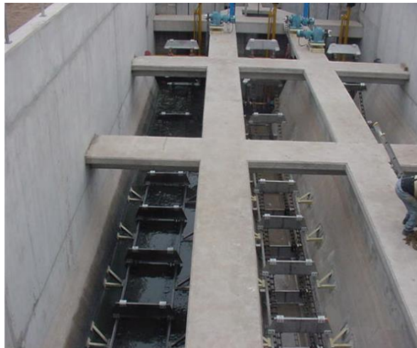
Figura 2.7. Canales desarenadores con limpieza mecánica. Fuente: CONAGUA, 2015
