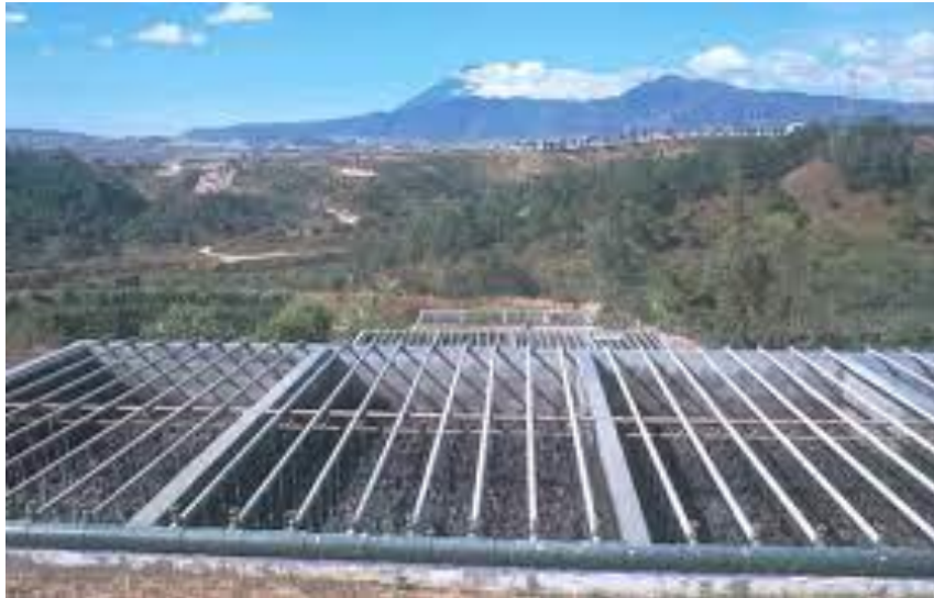
Figura 3.15 Filtro percolador rectangular con rociadores fijos.
