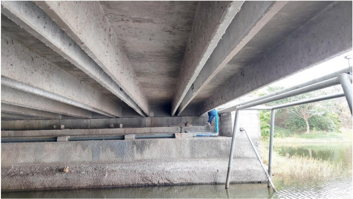
Ilustración 2.3 - Parte inferior del puente.
