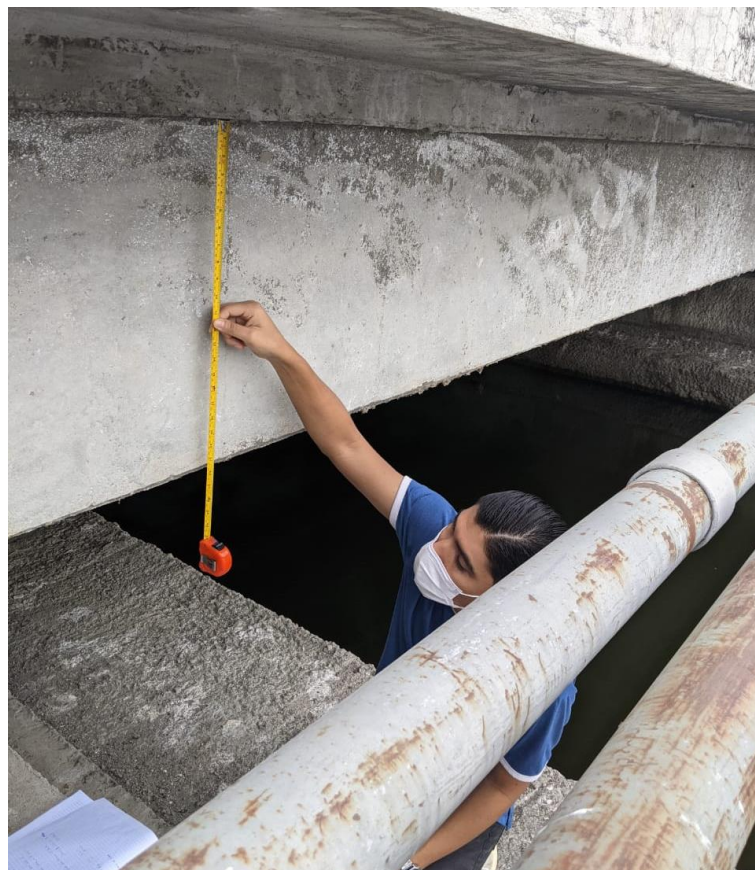
Ilustración 2.4 - Toma de medidas del puente.
