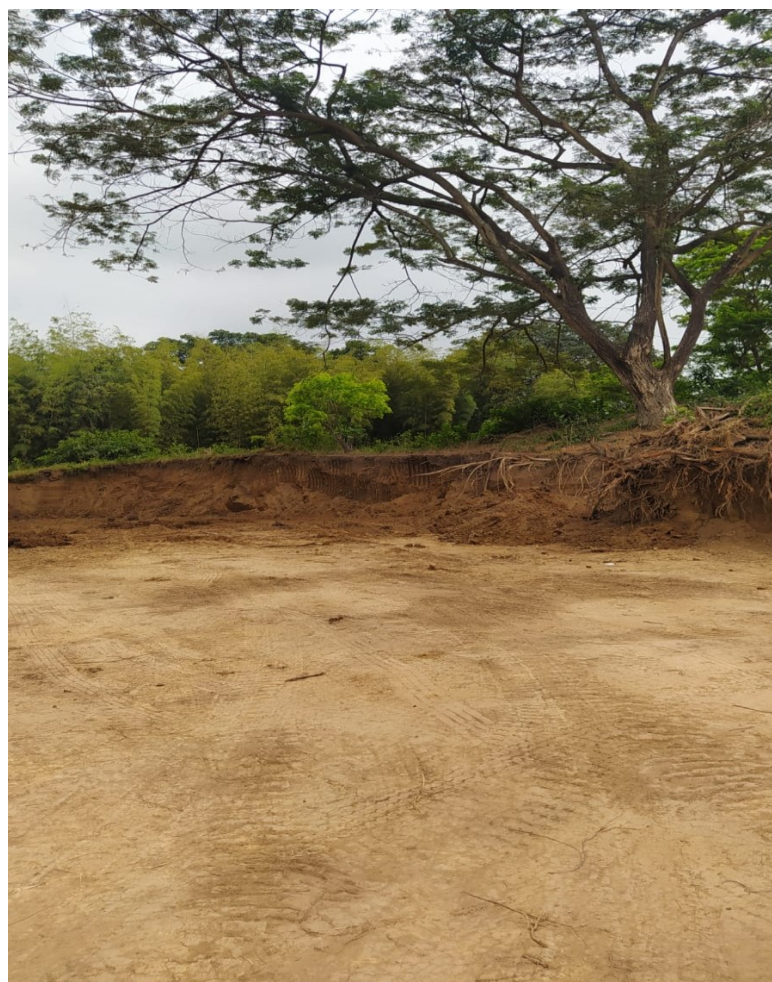
Figura 5.45: Tola SA-01-144 afectada por la minería de tierra.
