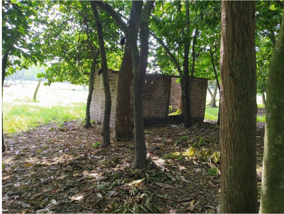
Figura 1. Construcción de casa
