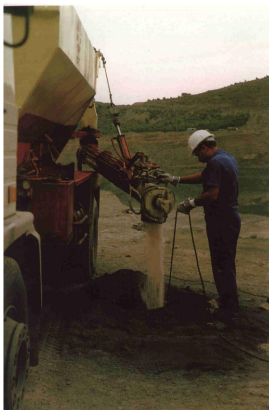
Figura 1. 5 Camión de Nagolita en labores de carga de barrenos de gran calibre (Cortesía UEE, S.A.)
