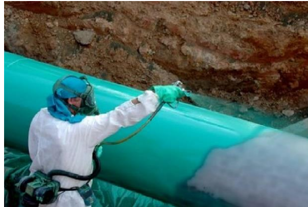
Figura 1.4. Recubrimiento epóxico para protección de tuberías enterradas.
