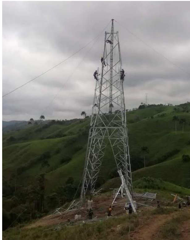
Figura 2.6 Montaje de una torre de transmisión de alta tensión
