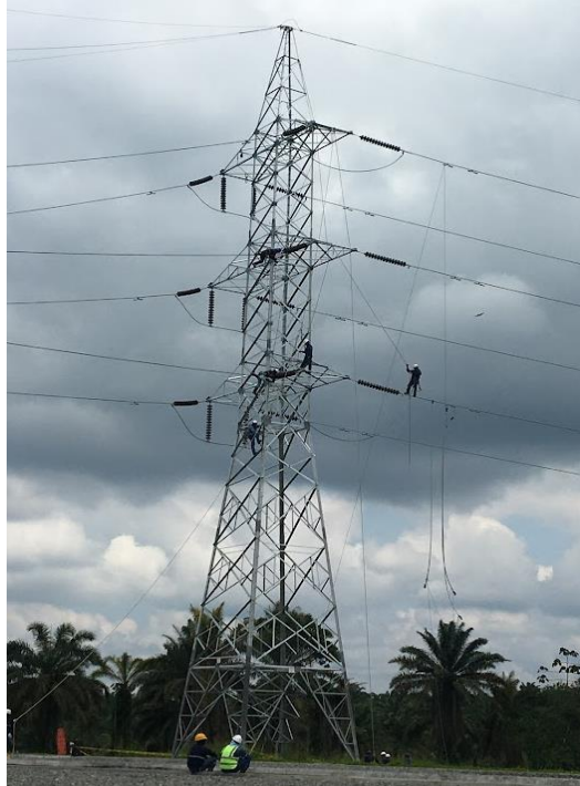
Figura 2.9 Tendido y regulado de una línea de transmisión de alta tensión
