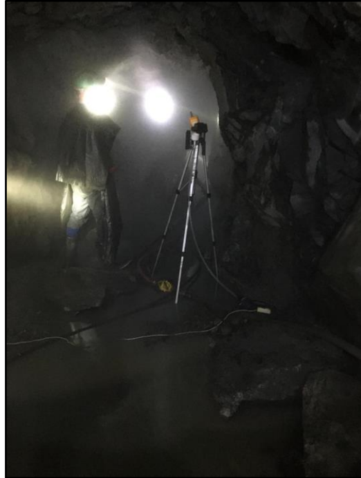
Figura A1: Medición de material particulado en el frente de trabajo
