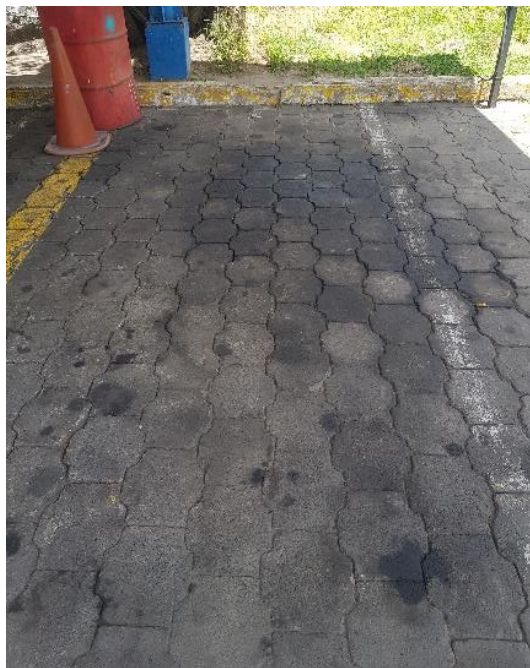
Foto 4.2.- Áreas de estaciones de servicio adoquinadas con contaminación
