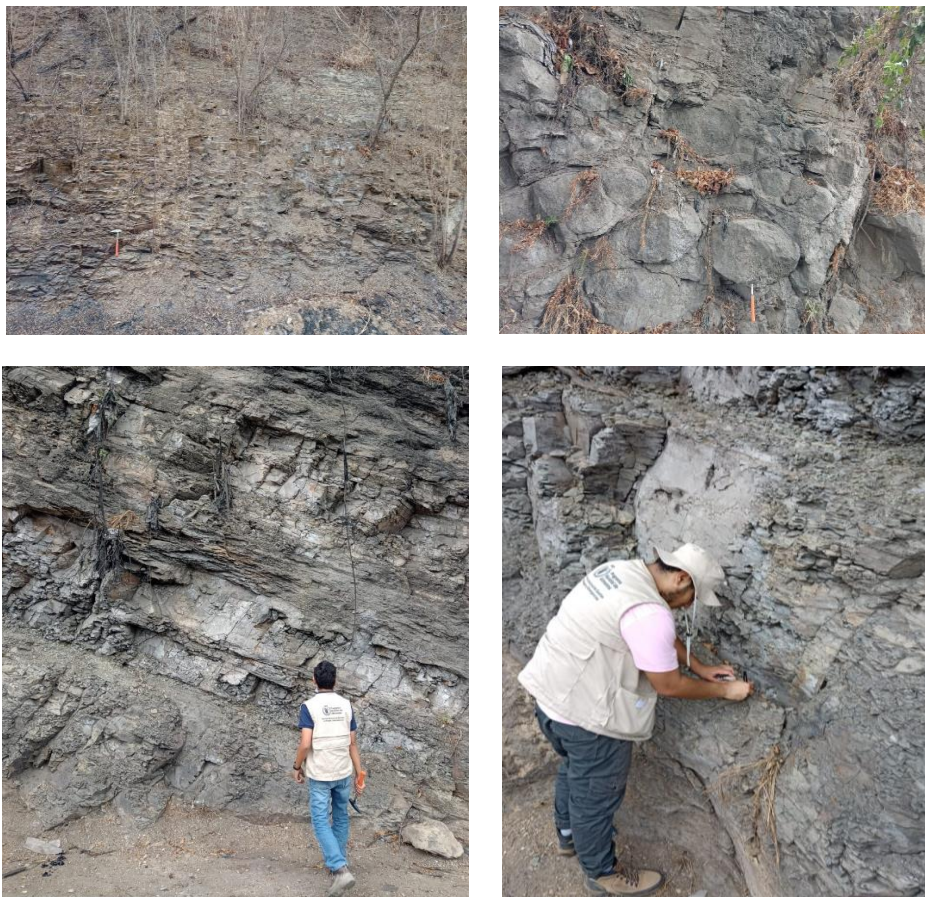
Figura 3.10 Trabajos de campo realizados en la Vía Perimetral y PARCON ESPOL
