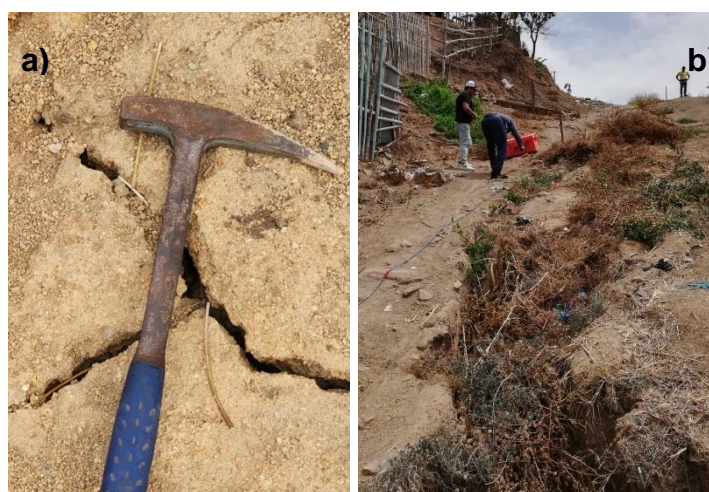
Figura 4.4 Grietas de tracción en los movimientos en masa activos.
