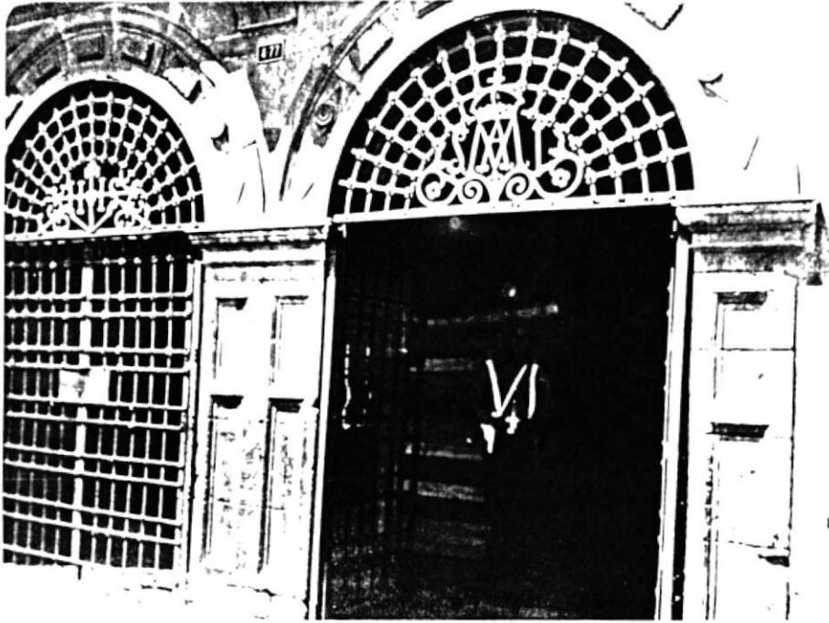
Puertas de acceso al área del zaguán
