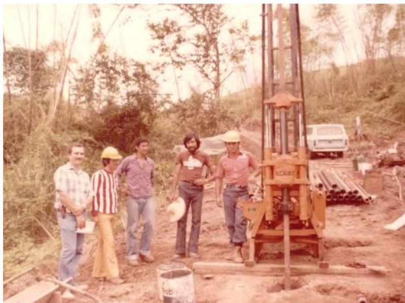
Equipo de Perforación para obtener testigos de roca
