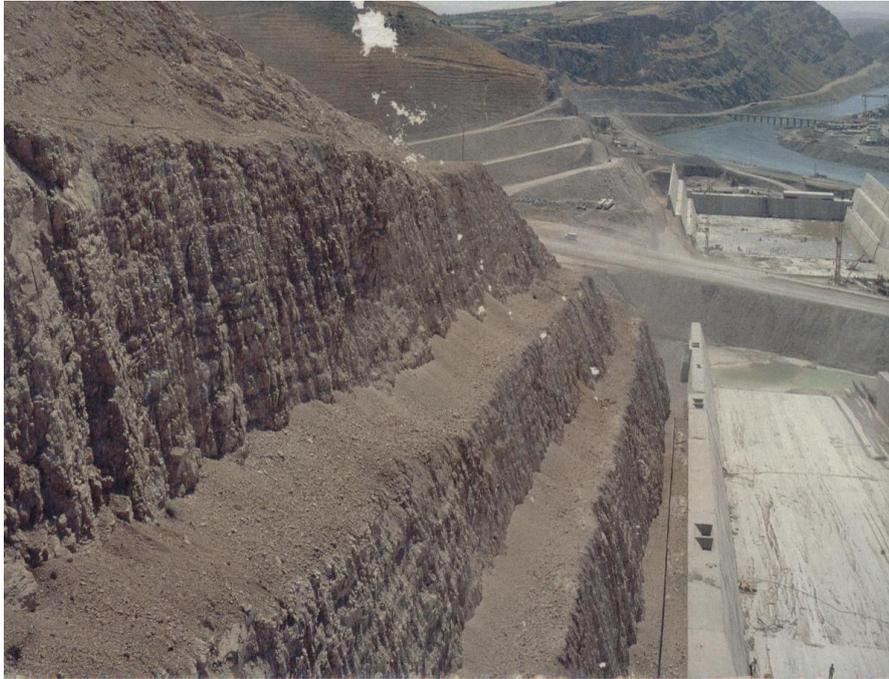
**Excavación en bancos en una cantera de explotación de áridos para hormigón**
