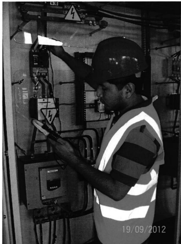
Figura 15: Revisión de voltaje
