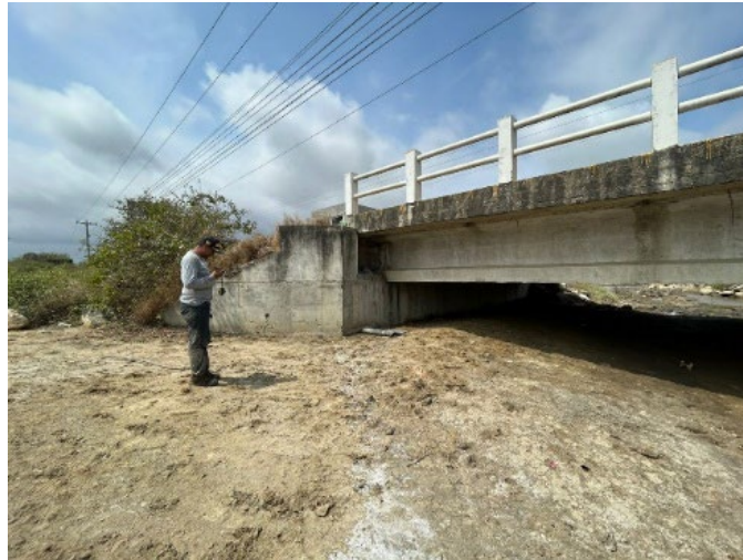
Figura 2.10 Toma de medidas del puente El Palmar
