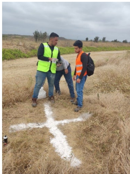
Figura 2.6 Marcación de punto de control con cal
