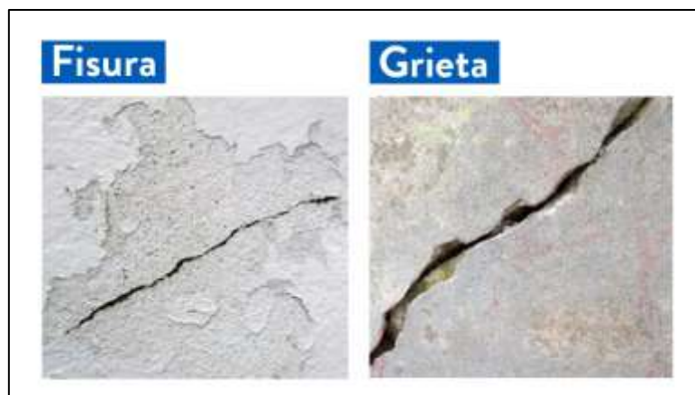
Figura 5. Diferencia entre fisura y grieta (Fuente: ClubMaestros).
