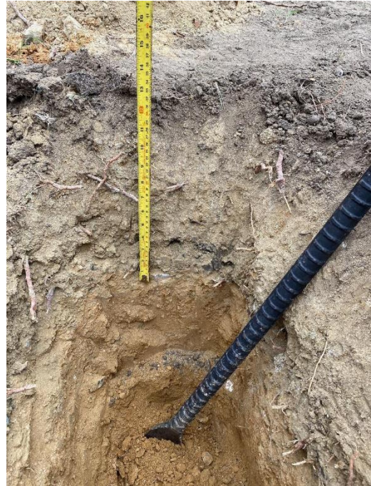
Figura 2.11 Excavación de calicata (Demera, 2024)
