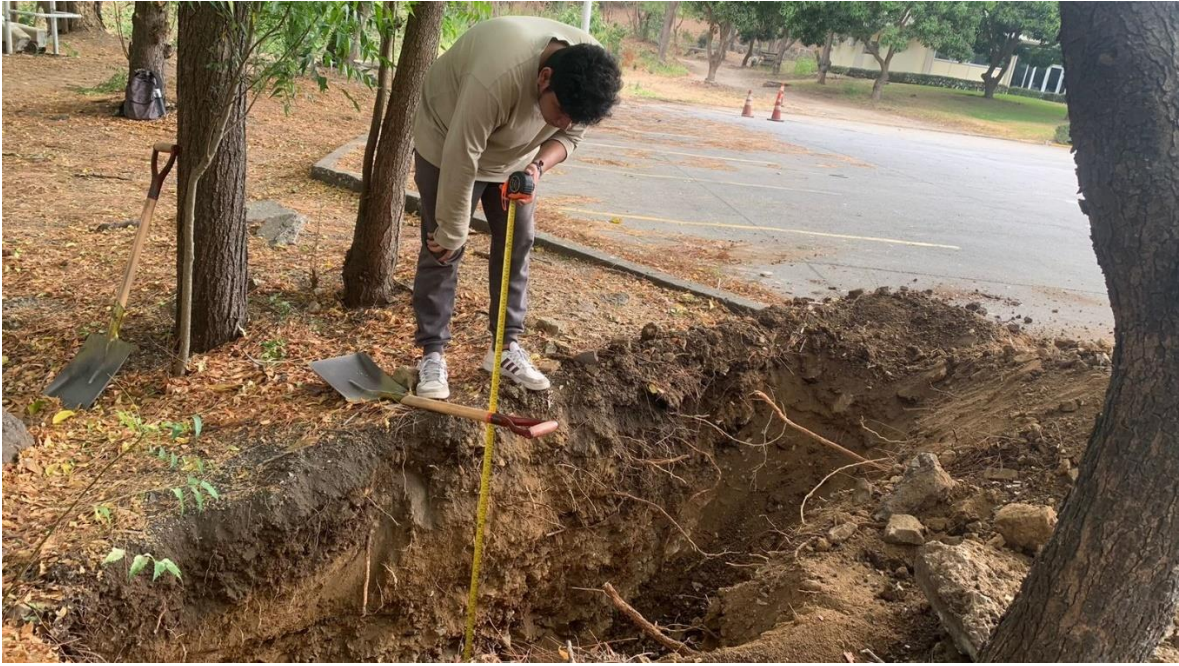
Medición de la profundidad de la calicata
