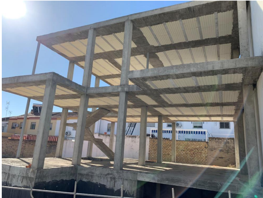
Figura 2.12 Estructura de hormigón armado (El caracol, 2019)
