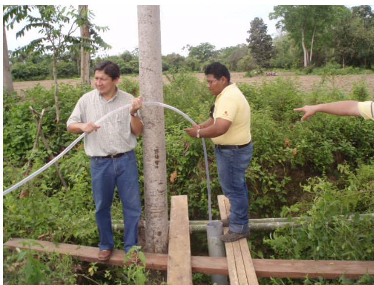
Foto. 4.11.- Vertido de la disolución del NaCl en el pozo
