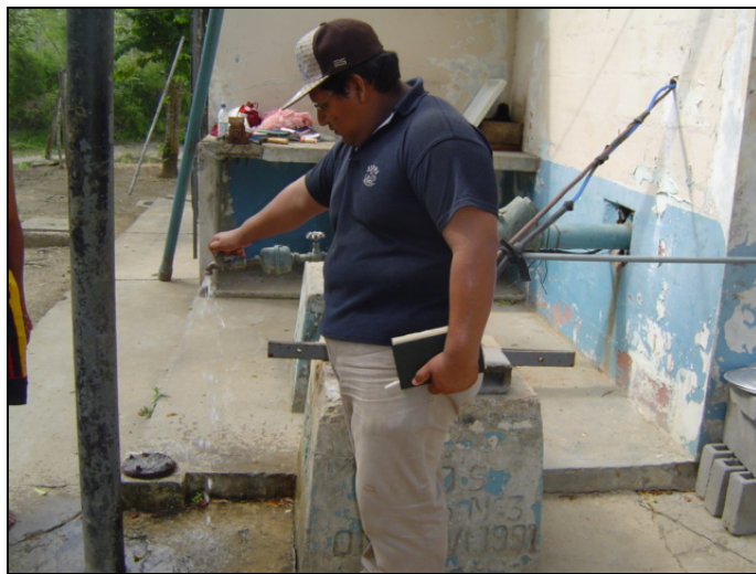
Foto. 4.2.- Pozo operativo de extracción de agua subterránea de la JRAO.
