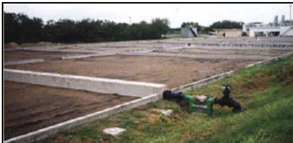
Figura 1.15 Lecho de Secado de Arena (27) .
