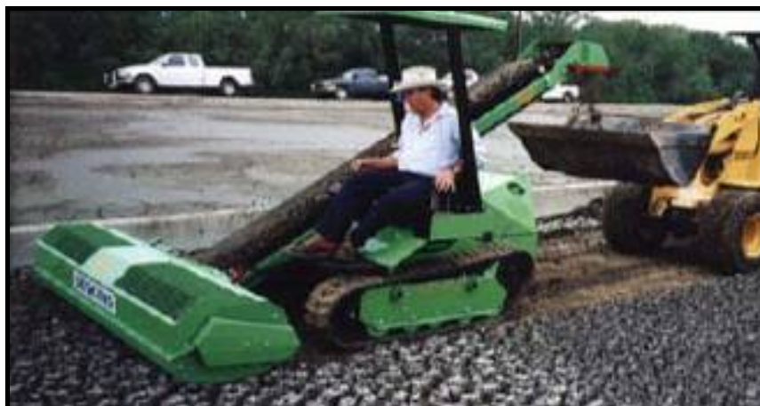
Figura 1.16 Lecho de secado pavimentado (28) .
