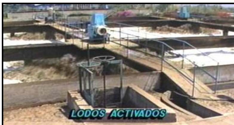
Figura 1.11 Tratamiento secundario: Lodos Activados (23) .
