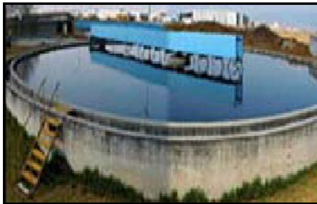
Figura 1.5 Tanque clarificador Secundario de forma circular (12) .
