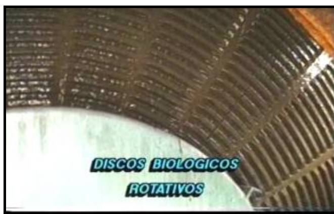
Figura 1.13 Tratamiento secundario: Bio discos (25) .
