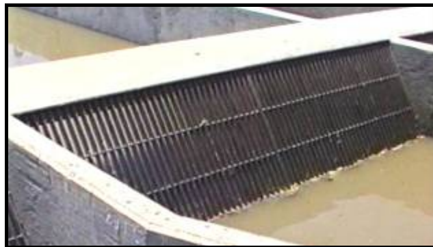
Figura 2.2 Rejas para tratamiento primario en STARD (66) .
