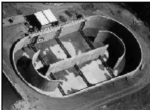
Figura 1.12 Tratamiento secundario: Zanjas de Oxidación (24) .
