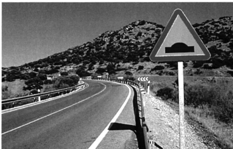
FIGURA 2.2 : Replanteo de una carretera.
