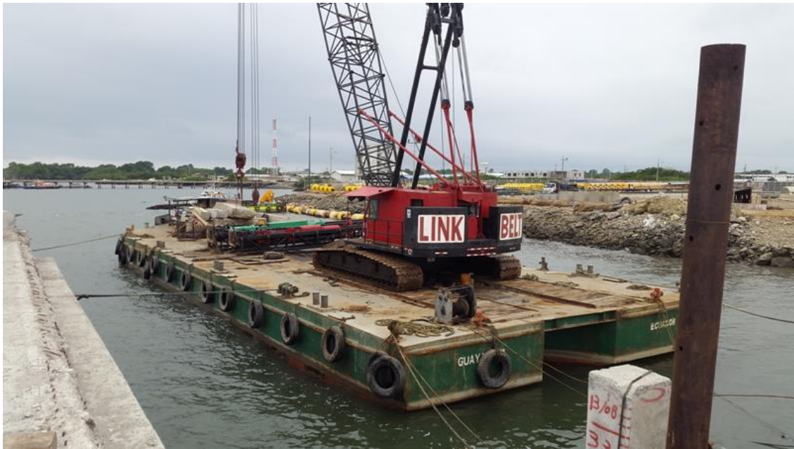
Ilustración 28. Barcaza con grúa de 150 Ton. Muelle 5. COPCI. Puerto Bolívar.
