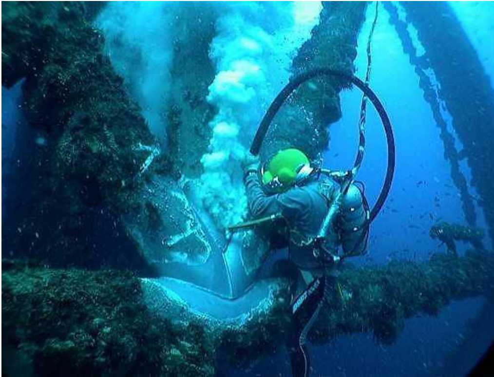
Ilustración 29. Limpieza de estructura submarina en plataforma.
