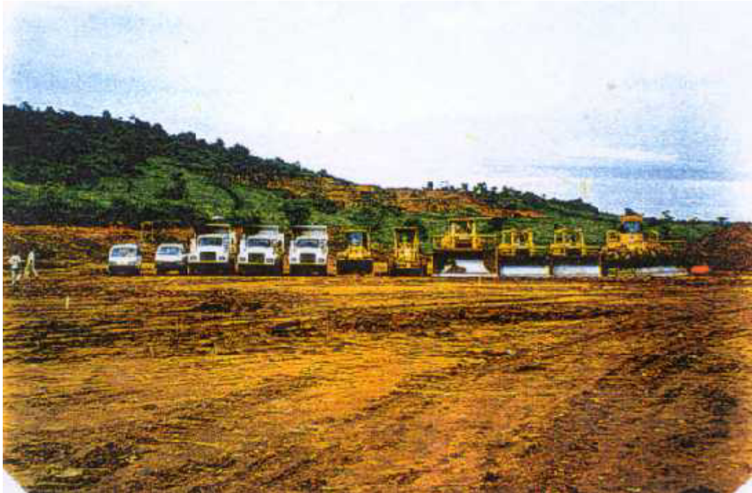
Gráfico18. Imagen del Sector del Relleno Sanitario Las Iguanas donde se ubicará el proyecto de Arco Plasma. FuenteBiomax S.A.
