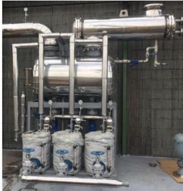
Figura. Nuevo sistema de recuperación de condensado
