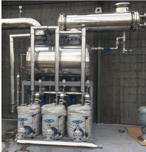
**Figura 7. Sistema de recuperación eficiente de condensados**
