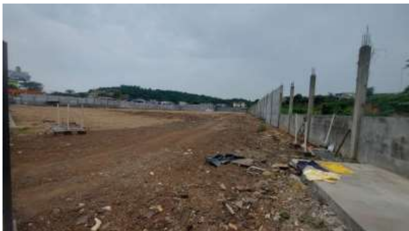
Figura 2 Cercamiento del Terreno Los Geranios
