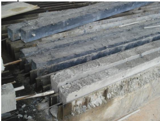
Figura 6. Desmolde de viguetas pretensadas. Izquierda viguetas de HAD, derecha hormigón convencional.
