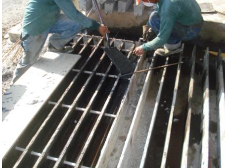
Figura 5. Vertido del Hormigón de Alto Desempeño en los moldes de las viguetas pretensadas.
