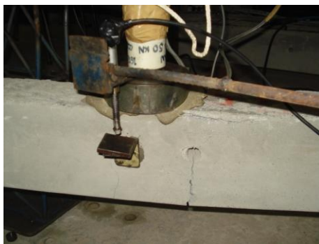
Figura 9. Detalle de fisura en la zona de falla de la viga construida con hormigón convencional (vista posterior).
