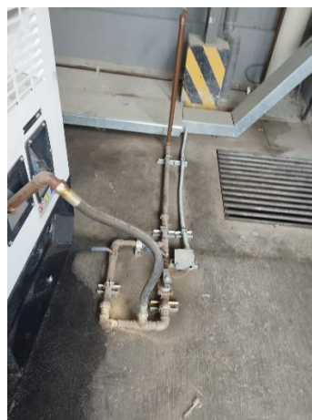
Ilustración 3.29 Conexión de electroválvula
