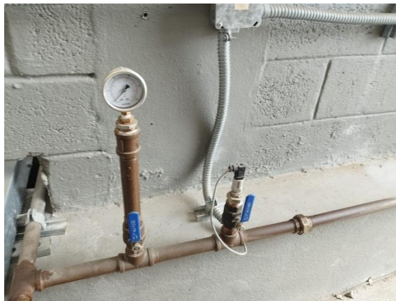
Ilustración 3.31 Conexión de sensor
