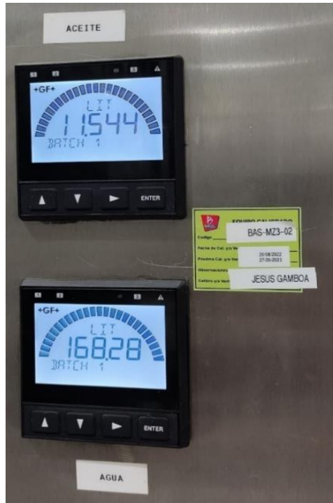
Figura 65. Sistema de pesaje de Harina, flujómetros de agua y aceite con la etiqueta de aprobación por parte del departamento de metrología.
