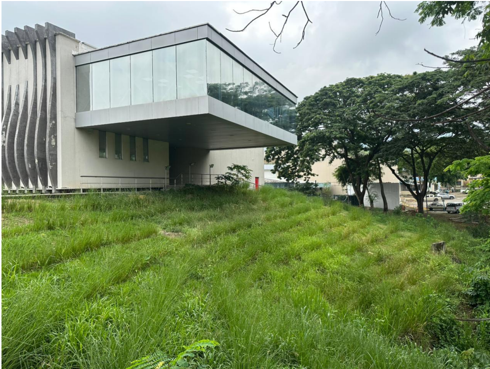
Figura 18. Uso de vetiver en el edificio de postgrados STEM, ESPOL.
